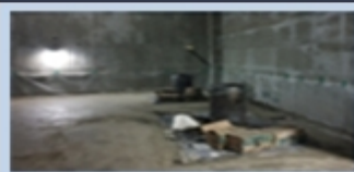
<저수조 콘크리트 양생>
